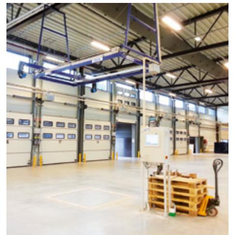
Deckenmodul Volumen, Bodenwaage eingebaut, Bedieneinheit
