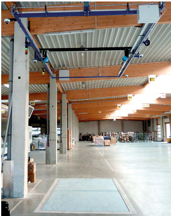
Volumenportal für die Erfassung von 2 Paletten mit Verbundwaage
